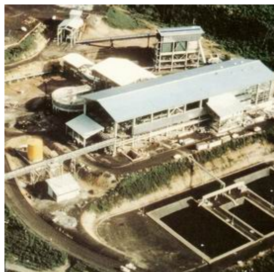
Usine de traitement (livret COMUF, 1983)
